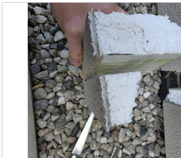
Foto: Spoj prelinky bez přesahu
