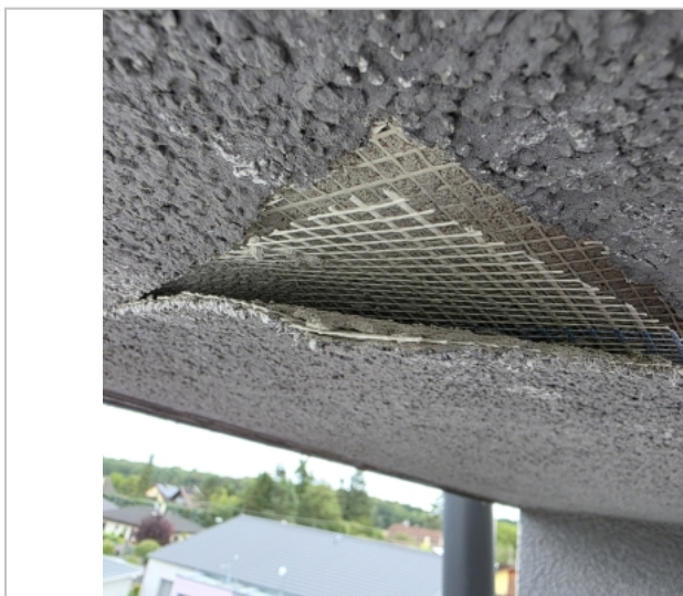
Foto: Tři vrstvy perlínky v sondě
