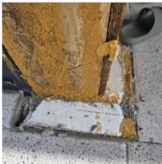
Foto: Tepelná izolace z EPS pod povrchem ter...
