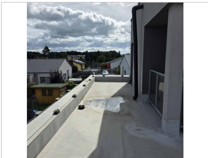
Foto: Část prostoru vymezeno pro terasu
