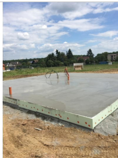
Foto: Foto základové desky (zdroj: Objednatel)
