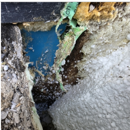
Foto: Dřevo pod úrovní terénu bez funkční izol...
