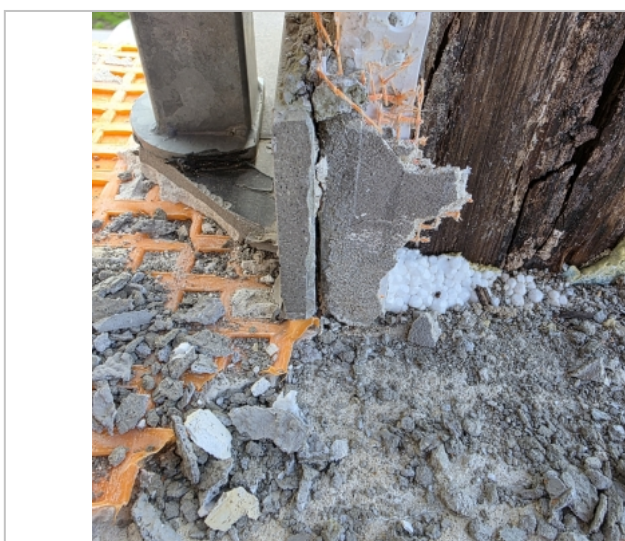
Foto: Způsob napojení skladby na dřevěný sloup
