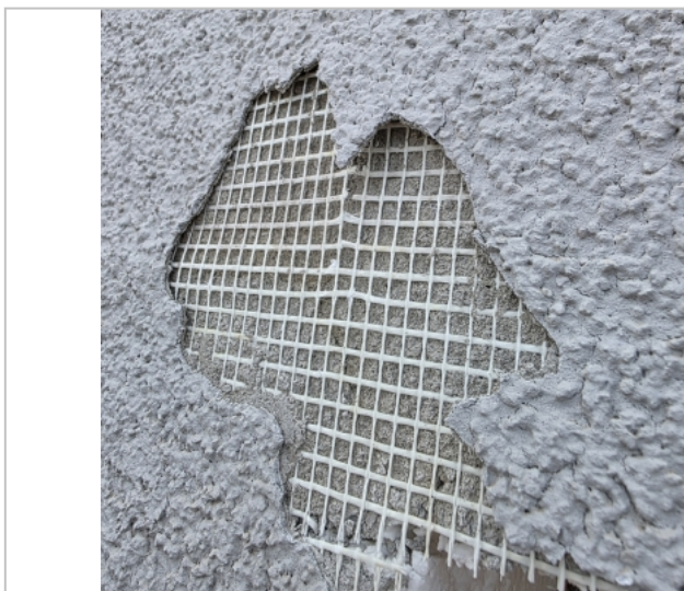
Foto: Poloha perlínky - není vtlačena do lepidla
