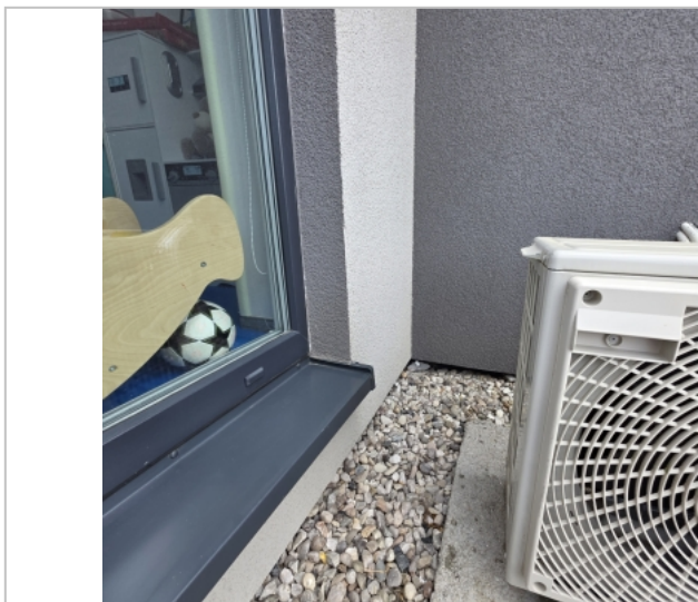
Foto: Oplechování parapetu
