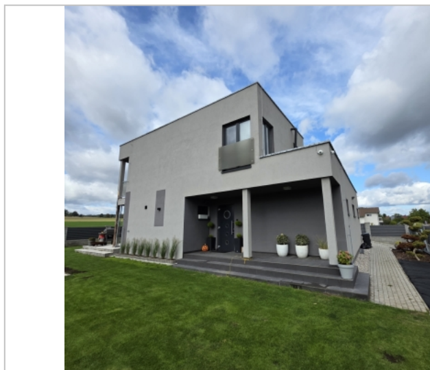
Foto: Jižní pohled
