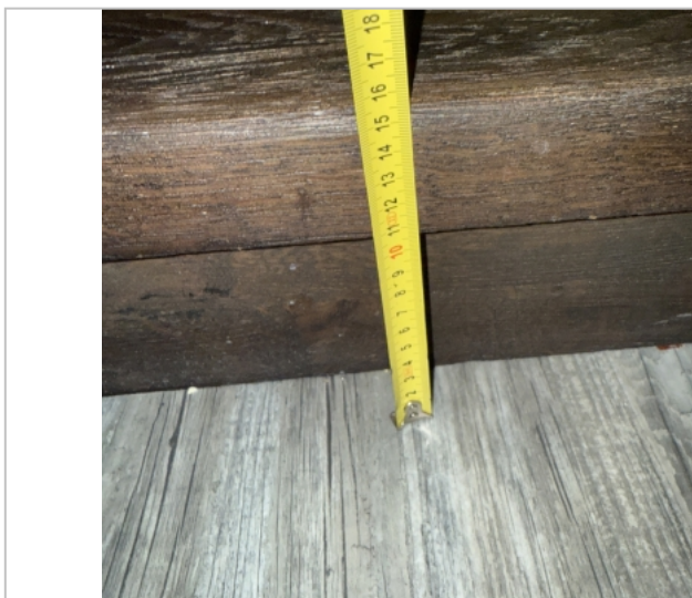
Foto: Výška stupně 155 mm
