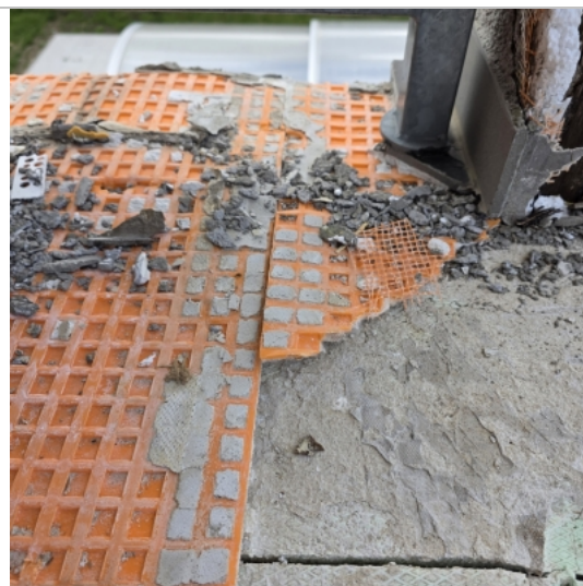
Foto: Detail vrstvy Ditra DRAIN na pozici hydroizolace...
