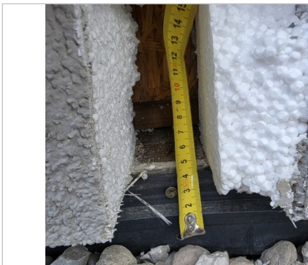
Foto: Tepelná izolace soklu z EPS
