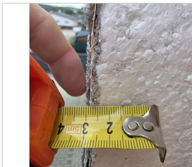
Foto: Minimální tloušťka výztužné vrstvy
