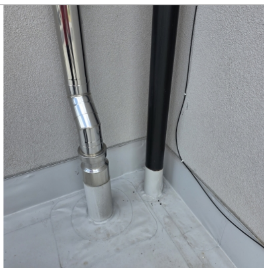
Foto: Absence stahovacích objímek
