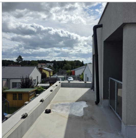
Foto: Pohled na střechu nad 1.NP
