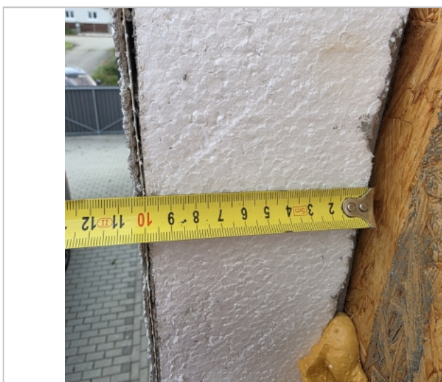
Foto: Tloušťka zateplení
