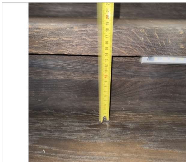
Foto: Výška stupně 185 mm
