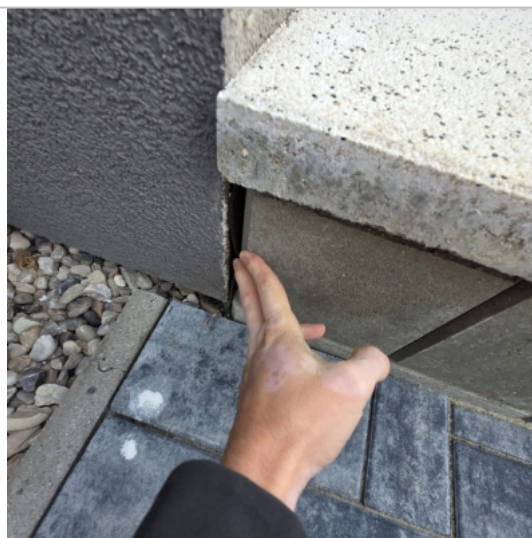
Foto: Svislá hydroizolace u začátku terasy
