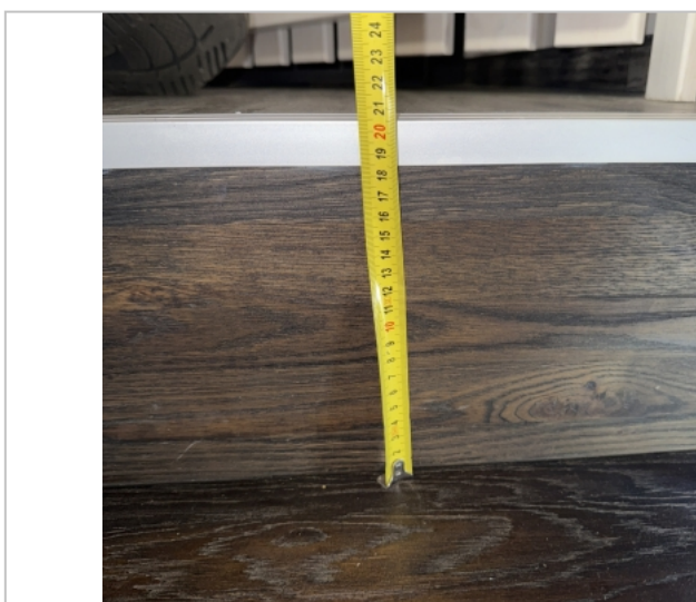
Foto: Výška jalového stupně 205 mm
