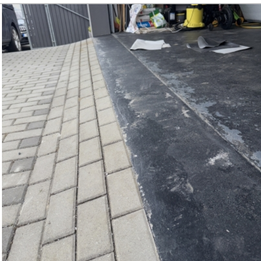
Foto: Návaznost podlahy a terénu u garáže
