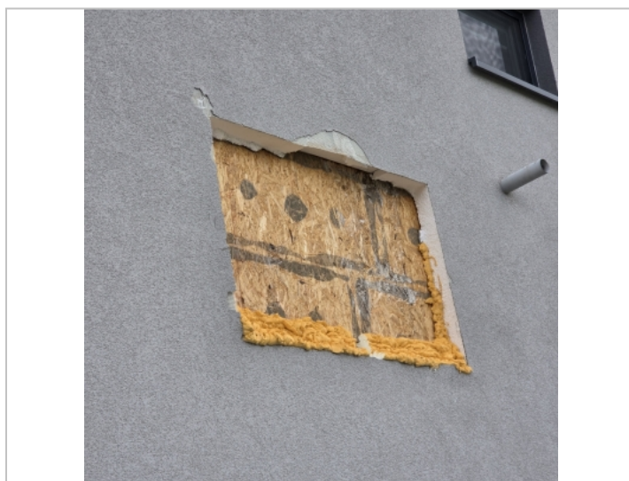
Foto: Sonda v místě přechodu stěn mezi podla...
