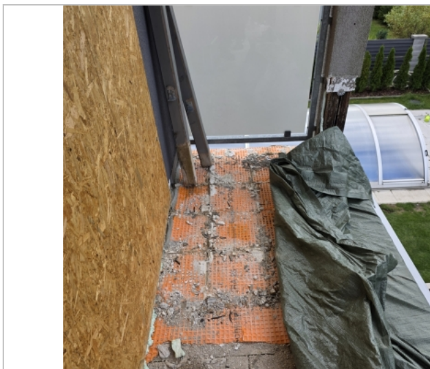
Foto: Pohled na skladbu balkonu - Ditra DRAIN
