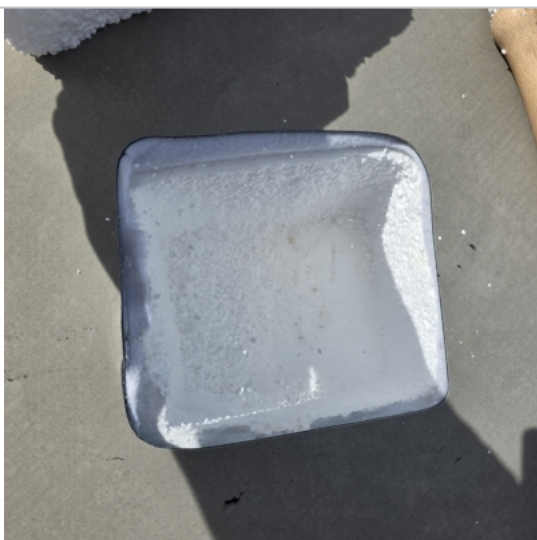
Foto: Sonda do střechy
