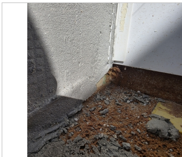
Foto: Nevzduchotěsná připojovací spára
