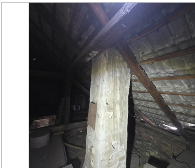
Foto: Dřevo u komínu v prostoru půdy
