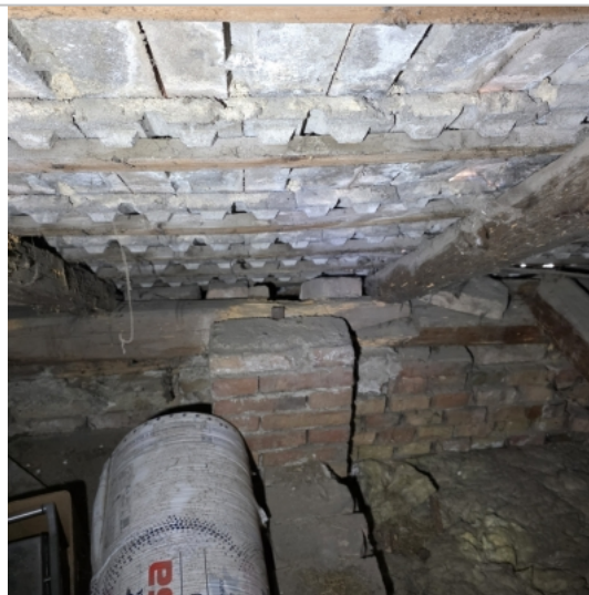
Foto: Střešní krytina z prostoru půdy
