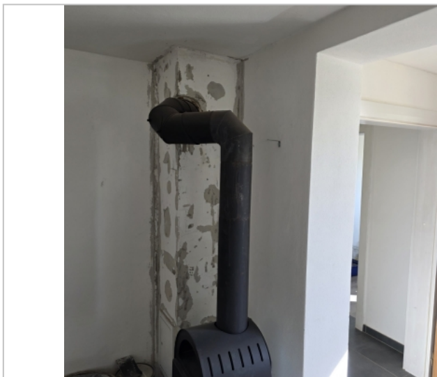
Foto: Komínové těleso po demontáži zateplení
