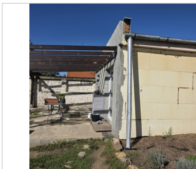
Foto: Zateplení u prostoru terasy
