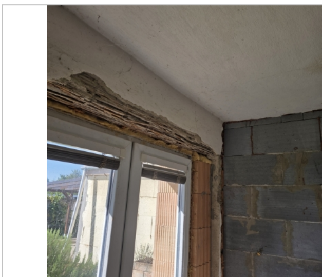
Foto: Zazdívka otvoru dřevěný překlád
