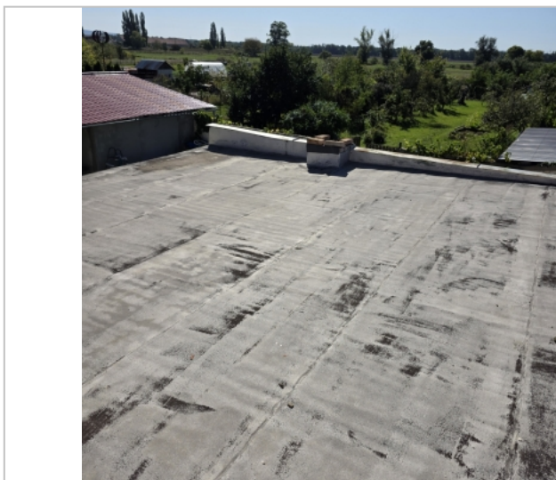
Foto: Částečný pohled na plochou střechu
