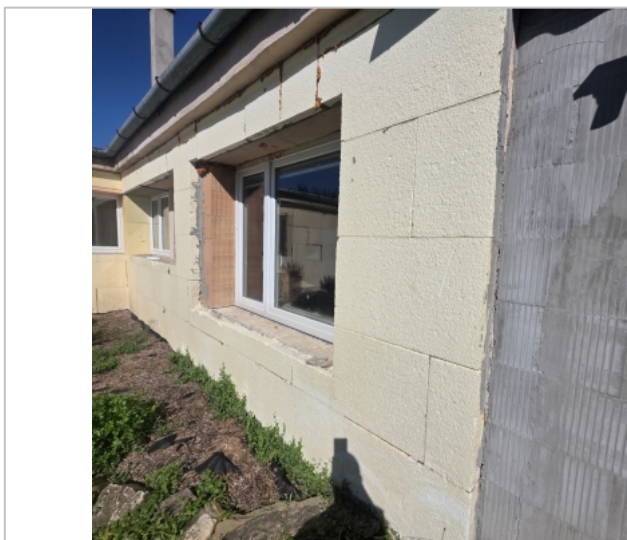
Foto: Soklová část zateplení z EPS
