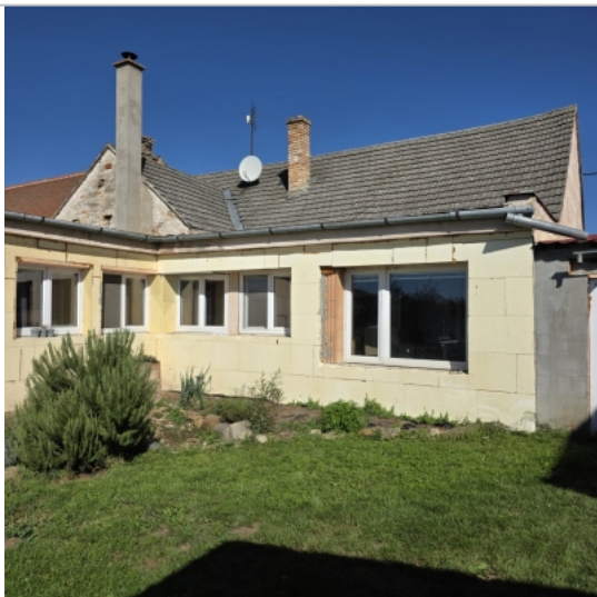
Foto: Sedlová střecha
