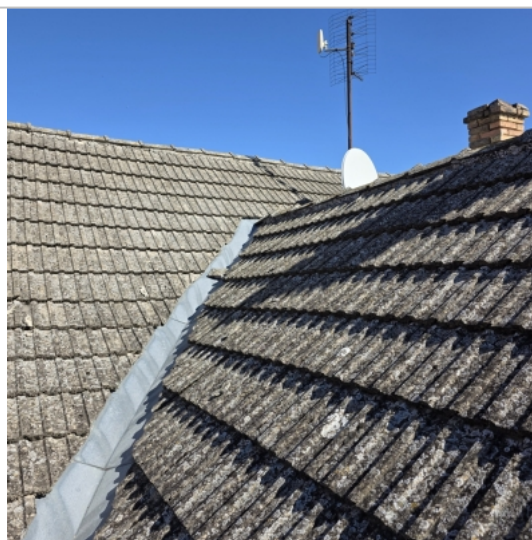
Foto: Stav krytiny z exteriéru
