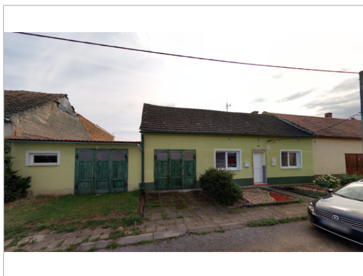
Foto: Jižní strana objektu bez zateplení
