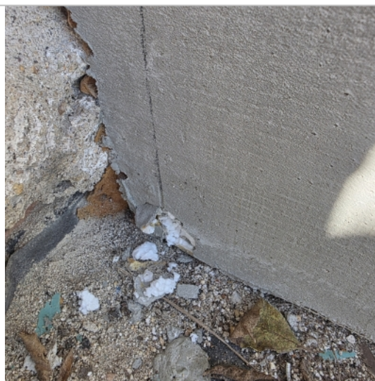
Foto: Soklová část zateplení z EPS
