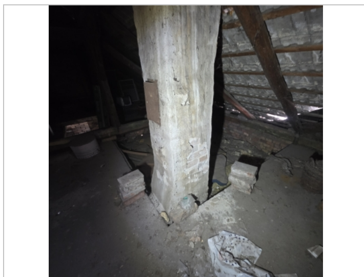
Foto: Betonová mazanina
