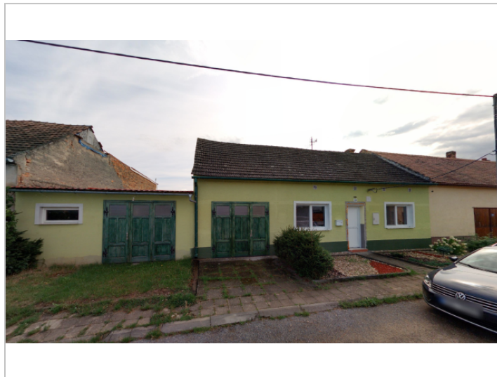
Foto: Jižní strana objektu bez zateplení
