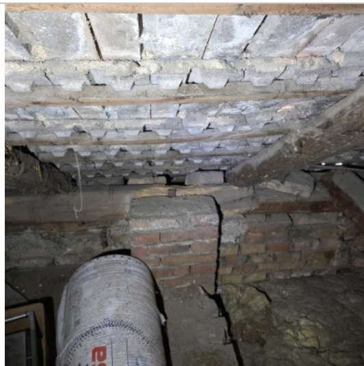
Foto: Střešní krytina z prostoru půdy
