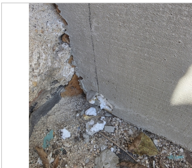
Foto: Soklová část zateplení z EPS
