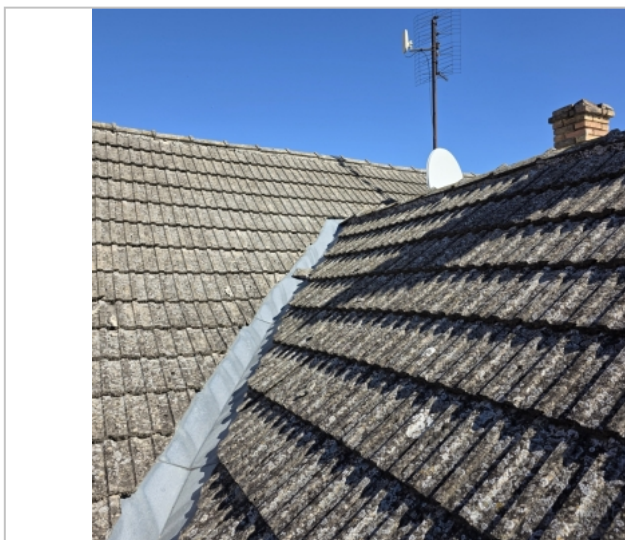
Foto: Úžlabní plech bez středového ohybu
