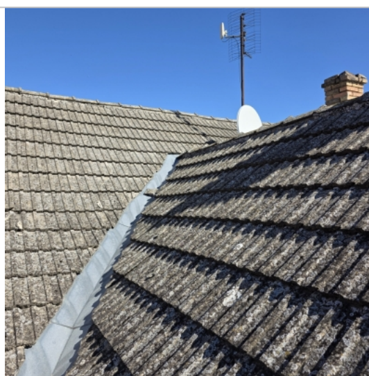
Foto: Stav krytiny z exteriéru
