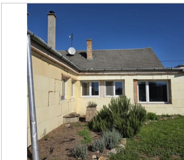
Foto: Jižní pohled na objekt
