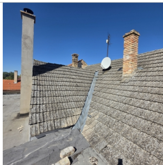
Foto: Nadstřešní část komínu
