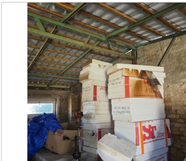
Foto: Absence zateplení u průjezdu
