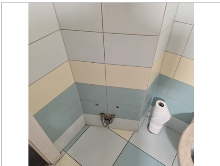
Foto: Obklad a dlažba v koupelně
