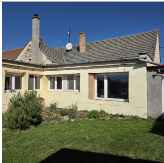
Foto: Sedlová střecha
