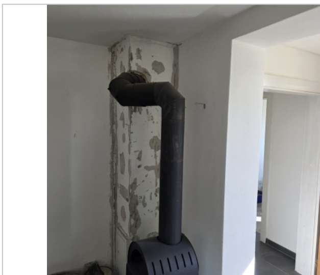
Foto: Komínové těleso po demontáži zateplení
