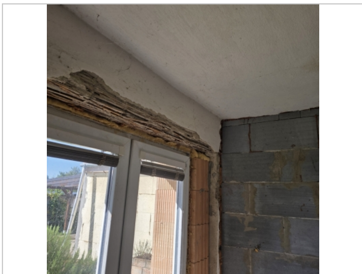
Foto: Zazdívka otvoru dřevěný překlad
