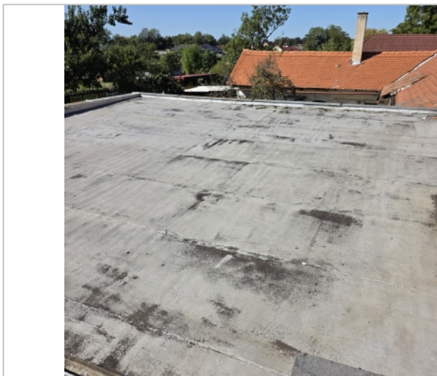
Foto: Plochá střecha
