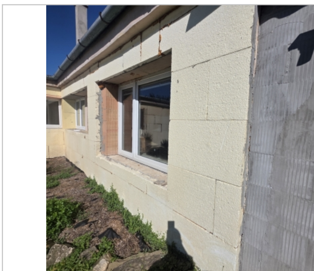
Foto: Soklová část zateplení z EPS
