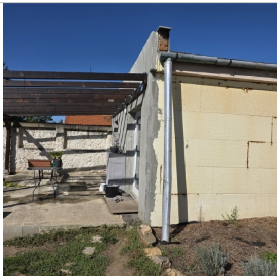
Foto: Zateplení u prostoru terasy
