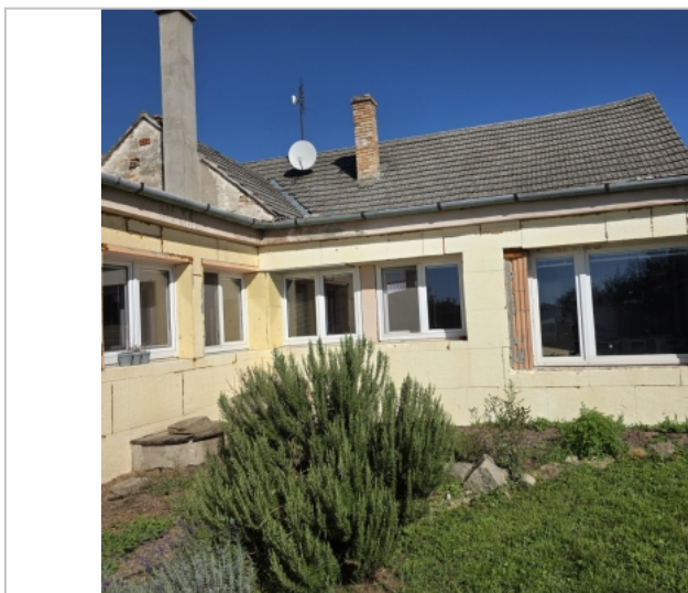
Foto: Nadstřešní části komínů
