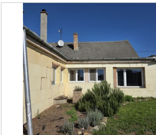
Foto: Jižní pohled na objekt
