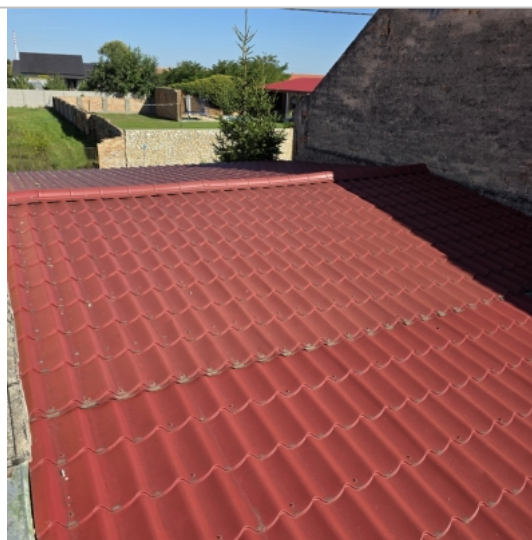
Foto: Střecha v prostoru bývalého průjezdu
