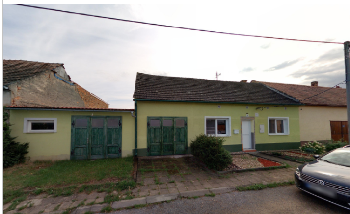
Foto: Severní pohled na objekt
