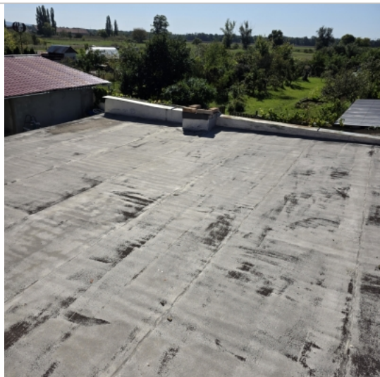
Foto: Částečný pohled na plochou střechu
