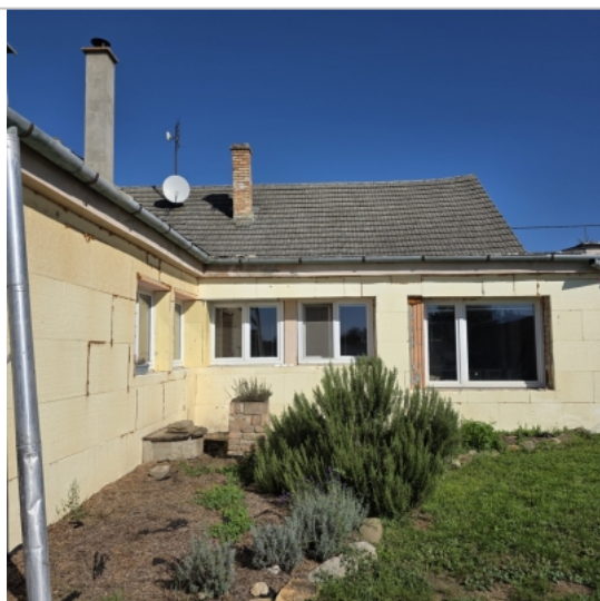
Foto: Jižní pohled na objekt
